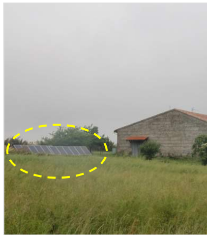
Panneaux photovoltaïques au sol
