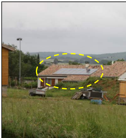
Panneaux photovoltaïques sur toiture
