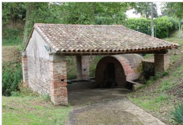
Figure 78 : Lavoir en brique foraine, source L'Artifex
