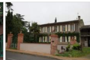
Ferme rénovée de Sacareau Source : L'Artifex
